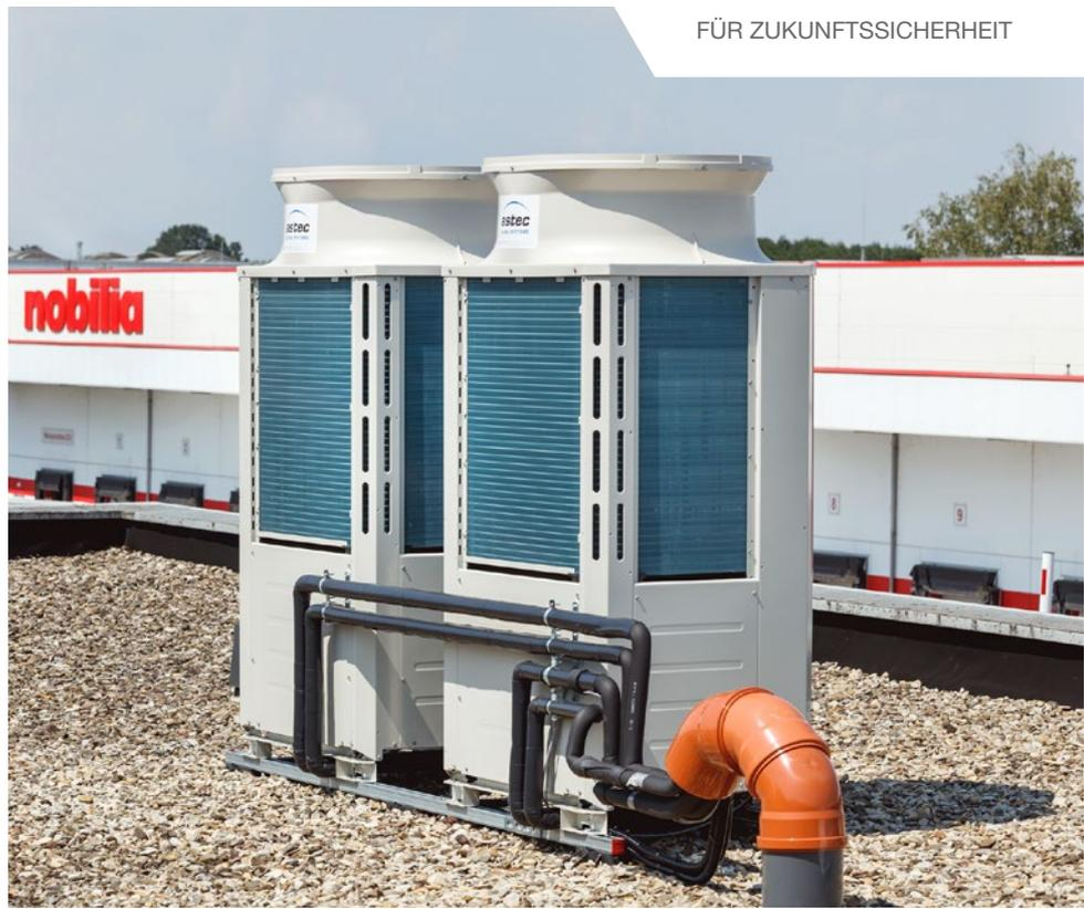
Das Flachdach des Bürogebäudes eignet sich optimal für den Aufbau der Außengeräte. Von hier aus versorgen die City Multi VRF-Einheiten die beiden Stockwerke mit genügend Kälte- und Heizleistung.
