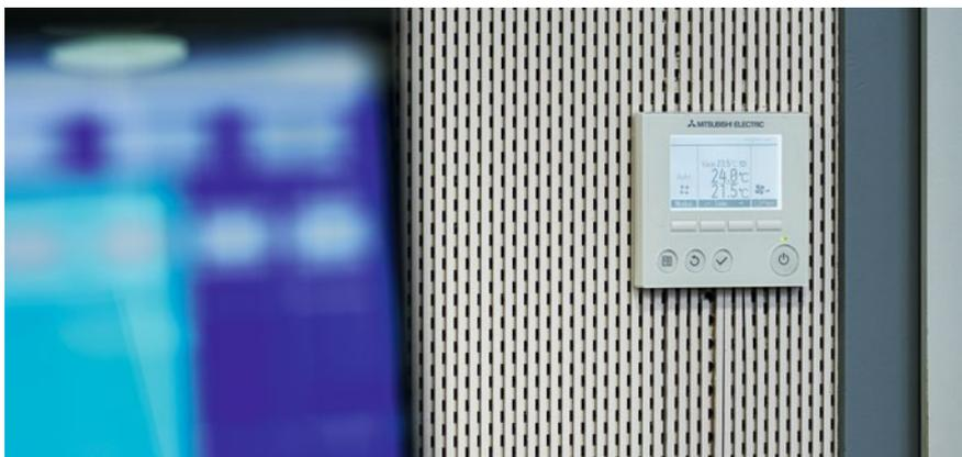
Die Luftansaugung erfolgt über einen stillgelegten Kamin, der Luftausblas über einen neu installierten Luftkanal. Jedes Kanaleinbaugerät kann unabhängig von den weiteren Innengeräten heizen oder kühlen. Die Einstellung erfolgt über je eine Kabelfernbedienung PAR-31MAA.
